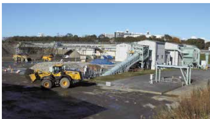
写真-2 中川建設発生土改良プラント
