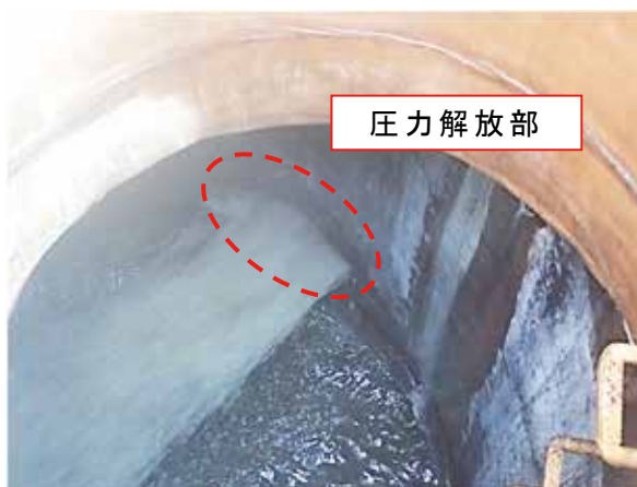
図 3 圧力解放部からの流入状況
