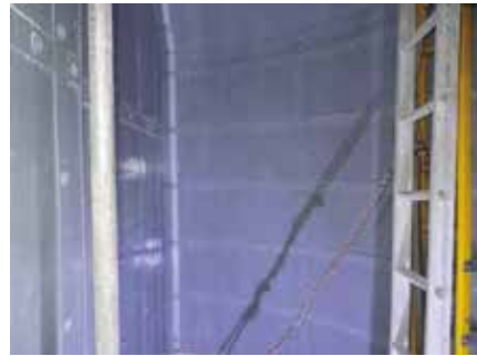
図10 D種シートライニング施工完了
