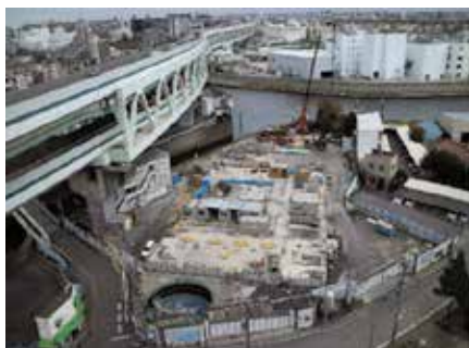
図 3 施工状況 (全景)
