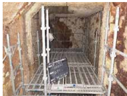
図 8 吊り足場設置状況(下流人孔)
