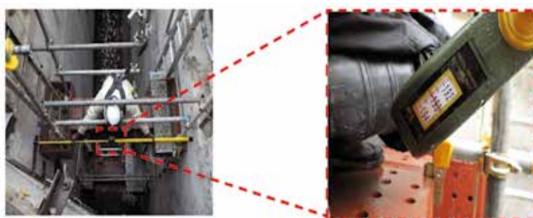
図 23 ケーソン間の離隔 測定状況
