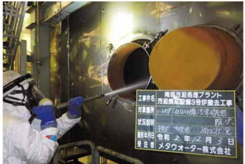
図5 機器洗浄状況
