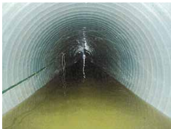
図 8 施工後の幹線内写真
