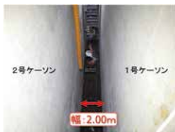
図 19 掘削状況（上部から） 図 20 掘削状況（側部） 図 21 掘削状況（底盤部）
