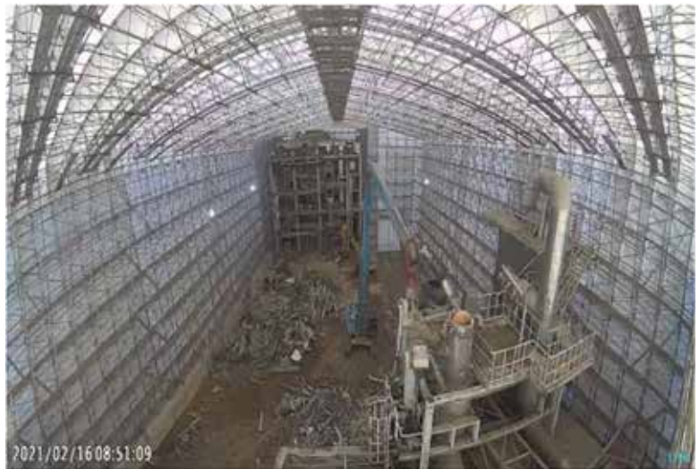
図6 機器撤去状況（ウェブカメラ）
