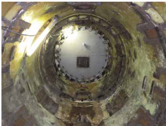
図6 発進立坑側からの仮壁設置状況
