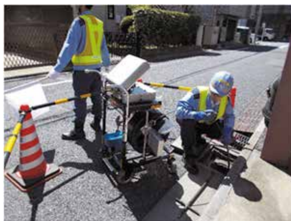
写真－4 公共汚水ます調査作業
