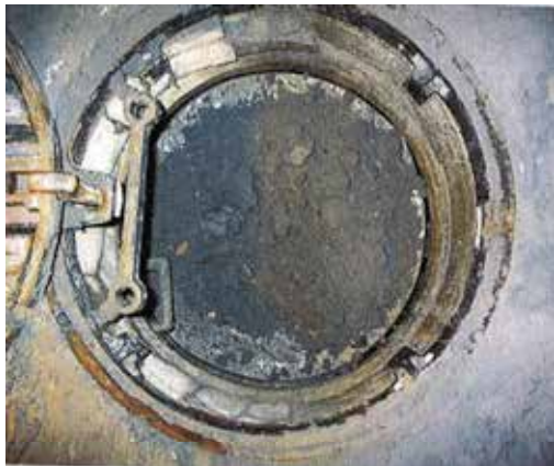
図3 □人孔の堆積土砂
