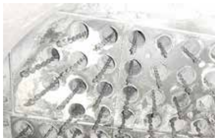
図11 流動空気予熱器内部
