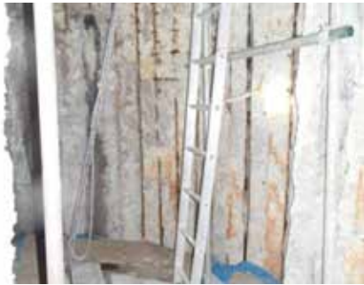
図9 D種シートライニング施工前
