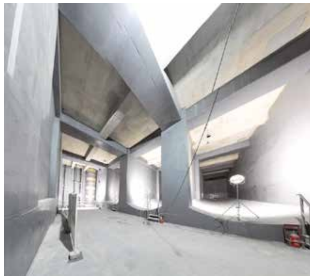
図6 雨水貯留施設内部
