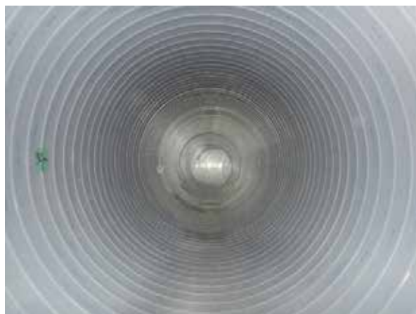
図 12 施工後の大手町幹線
