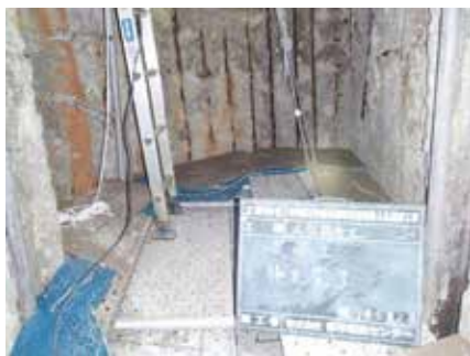
図 7 吊り足場設置状況(上流人孔)
