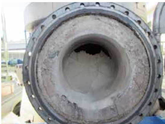
図 1 空気予熱器上部（煙道閉塞時）
