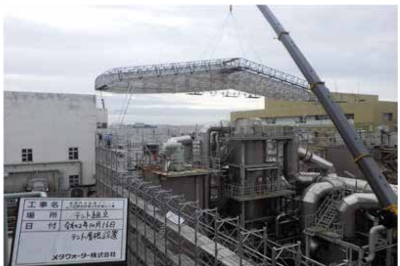
図4 テント(屋根部)設置状況
