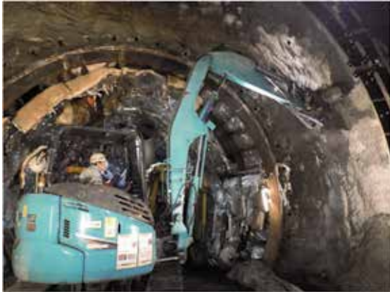
図12 凍土掘削状況
