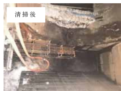
図 9 ふかし上げ人孔内清掃後の状況
