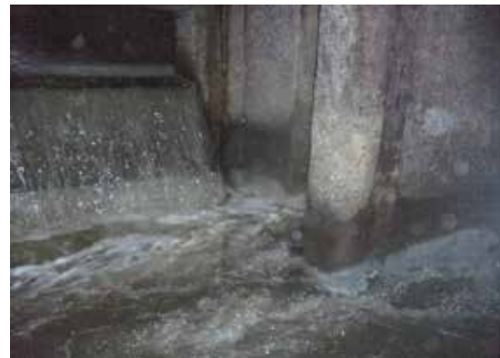
図 5 ドローン調査映像（幹線合流部）
