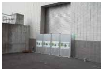
図 7 防音パネルの設置状況
