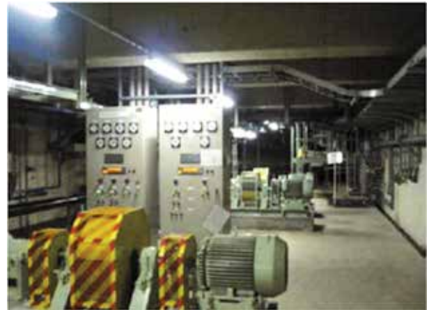
図2 支障となる稼働中設備類
