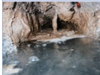
下水道管内の付着状況
