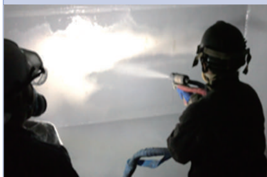
塗布作業状況
