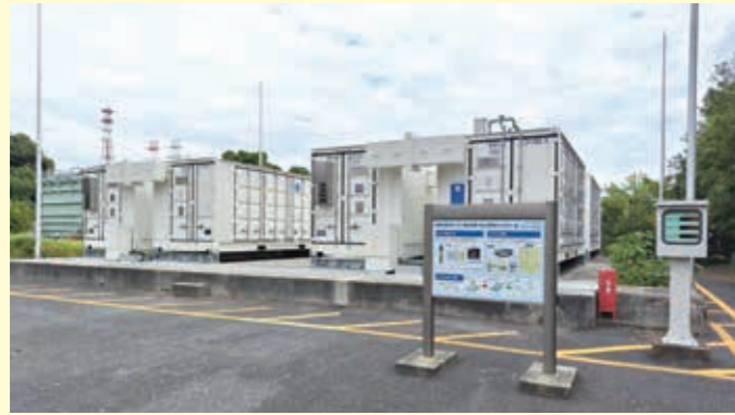
▲ 砂町水再生中心のNaS電池
