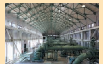
⑧ 泵房 安装的10台泵可把污水从地下的吸水井吸上来。
