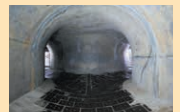
⑦ 泵井防水门室和水路 分为两个系统流入的污水在这里汇合，流入各自的吸水井。
