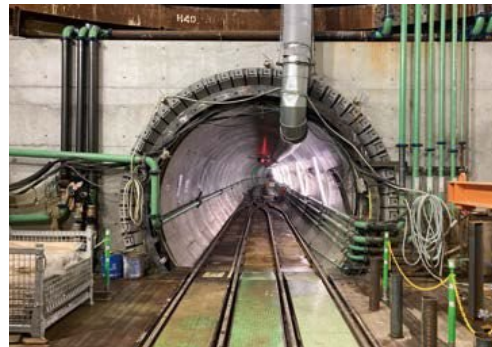
空堀川上流雨水幹線
