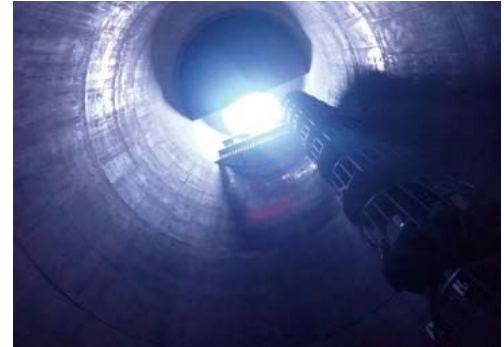
第二戸越幹線到達立坑
