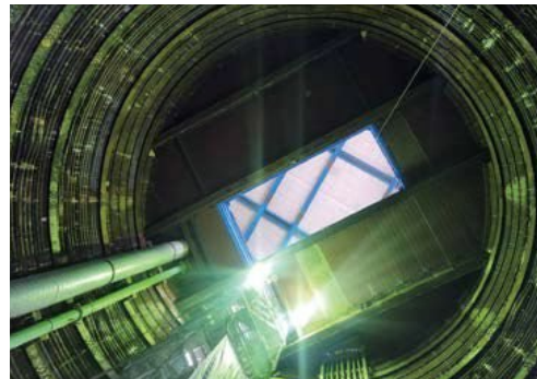
呑川増強幹線発進立坑
