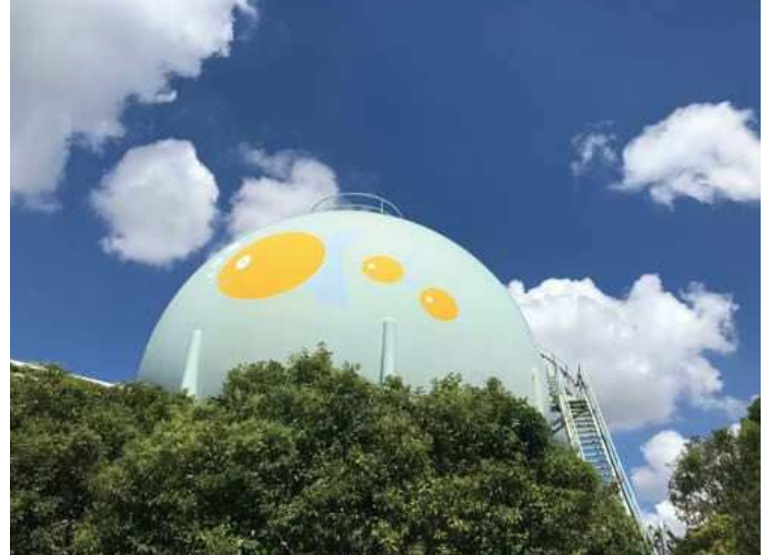
森ヶ崎水再生センター ガスホルター
