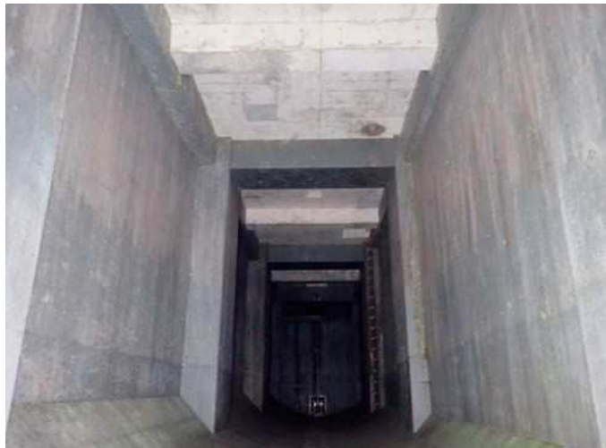
渋谷駅東口雨水貯留施設
