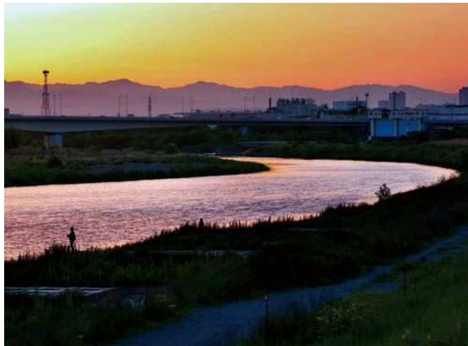
北多摩一号水再生センターの水門と多摩川
