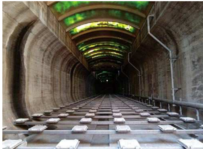
みやぎ水再生センター 西系雨天時貯留池
