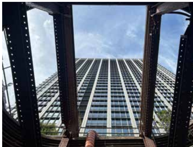
小判型立坑内から見た品川シーズンテラス
