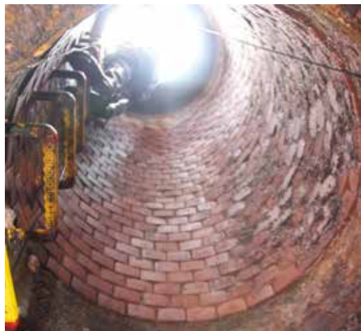
神田下水 マンホールを見上げて
