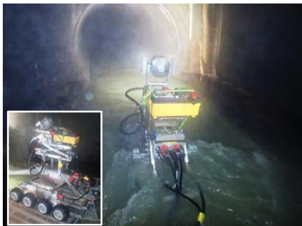
▲水位が高いなど目視調査が困難な大口径管きょ におけるテレビカメラを用いた管路内調査
