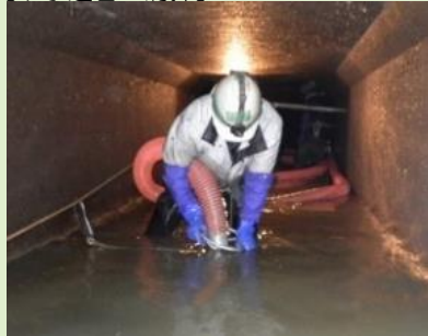
▲管路内に堆積した土砂等の清掃状況
