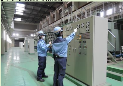
▲ポンプ用操作盤の点検
