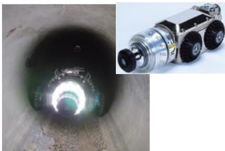
▲人の入れない小口径管きょにおける テレビカメラを用いた管路内調査
