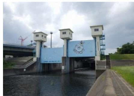
▲北多摩一号水再生センターの樋門操作訓練
