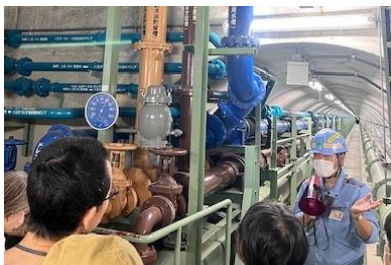
▲多摩川上流水再生センターを見学
