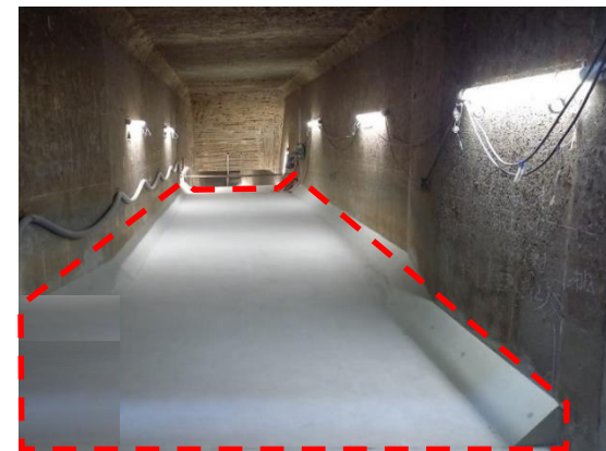
▲耐震補強を行ったポンプ所の放流きょ （浜町ポンプ所）
