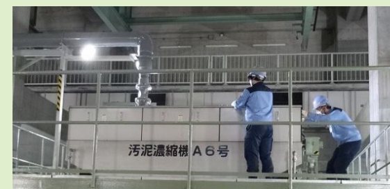
▲濃縮機の点検
