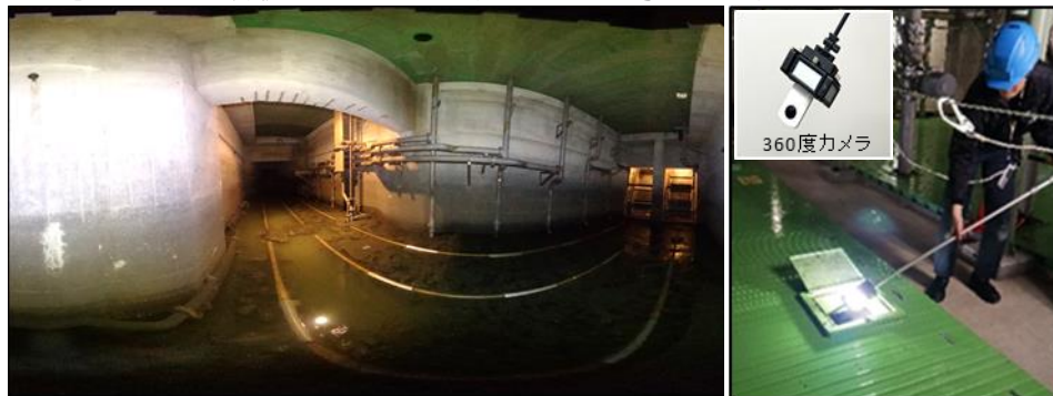
▲「360度カメラ」を用いて目視点検が困難な施設を調査
