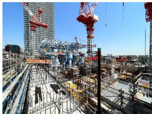
▲施工中の江東ポンプ所 (江東区木場、東雲地区)
