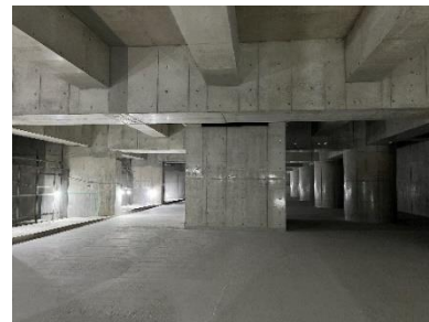
▲整備中の千住関屋ポンプ所
