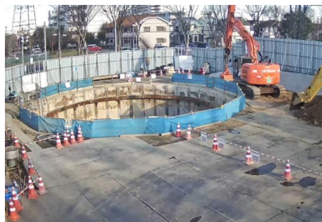
▲施工中の空堀川上流雨水幹線の発進立坑
