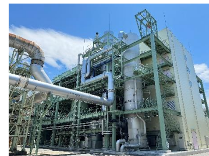
▲葛西水再生センターの汚泥焼却設備
