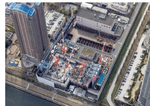
▲大規模なポンプ所工事
