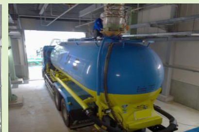
▲焼却灰を輸送車に積み込み搬出
