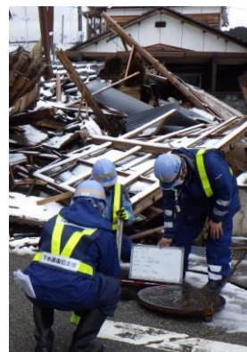
▲マンホールを開けて目視による被害確認を行う調査の様子
