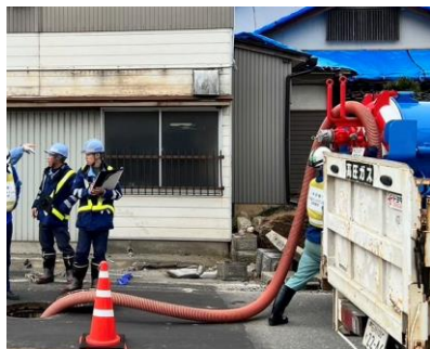
▲下水道管内の清掃作業
