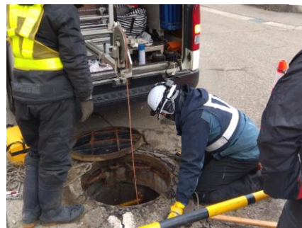
▲テレビカメラを使用した詳細調査
