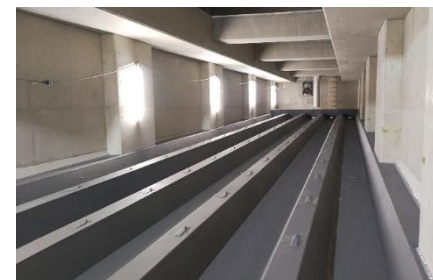
▲整備後の浮間水再生センター
