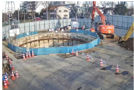
▲施工中の空堀川上流雨水幹線の発進立坑
