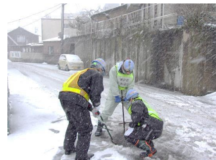
▲積雪など厳しい環境の中での作業の様子
