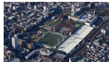
▲落合水再生センター
