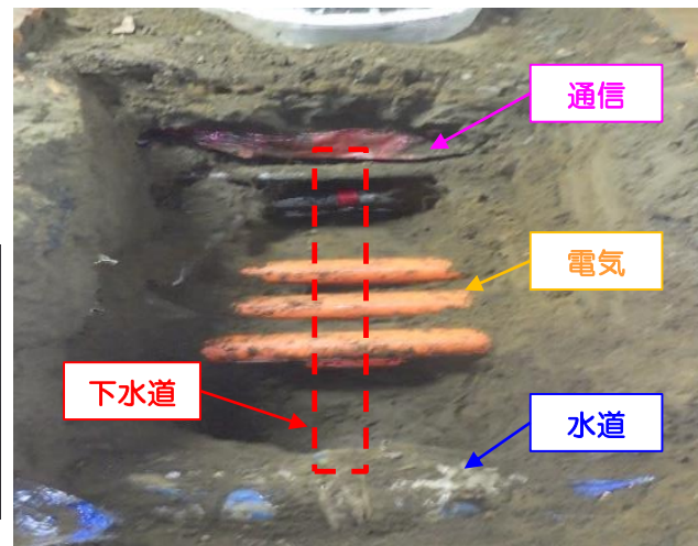
▲ 輻輳する地下埋設物
