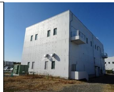
▲ポンプ棟 完成 (北多摩二号水再生センター)
