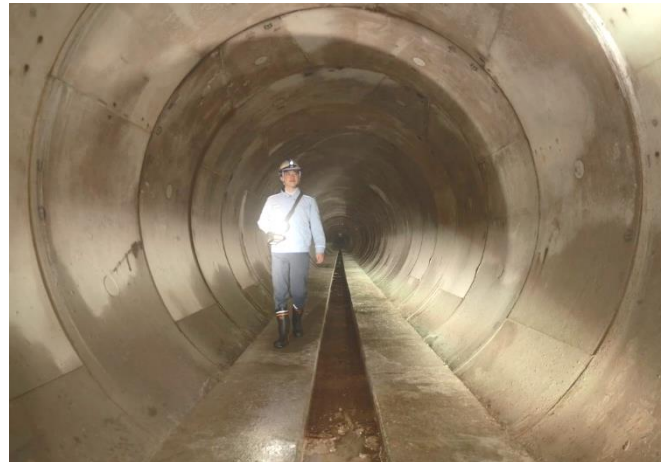
▲合流改善施設建設工事 （外濠貯留管）
