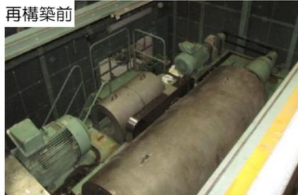
▲運転燃費の改善に加え、汚泥含水率を低減し焼却の際の省エネルギー化を実現する汚泥脱水機を導入（八王子水再生センター）
