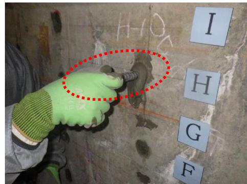
◀壁に鉄筋を挿入することで耐震補強を実施（北多摩一号水再生センター）
