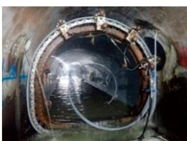
更生工法による幹線再構築
