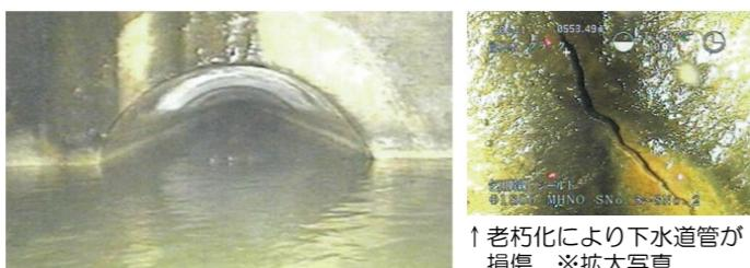
↑老朽化により下水道管が損傷 ※拡大写真
