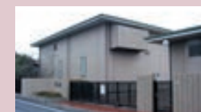
稲城ポンプ所 外観
