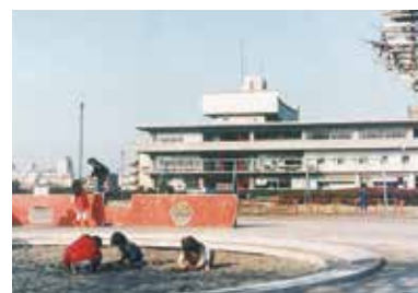
▲世界初の上利用公園(落合処理場)(昭和39年)
