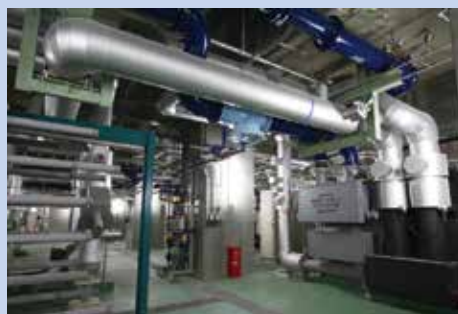
上部ビル全体の冷暖房を賄う 下水熱を利用した空調設備
