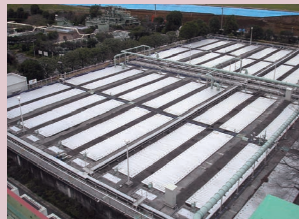
▲雨天時貯留池(北側)の上部
