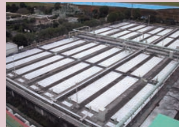
▲雨天時貯留池(北側)の上部
