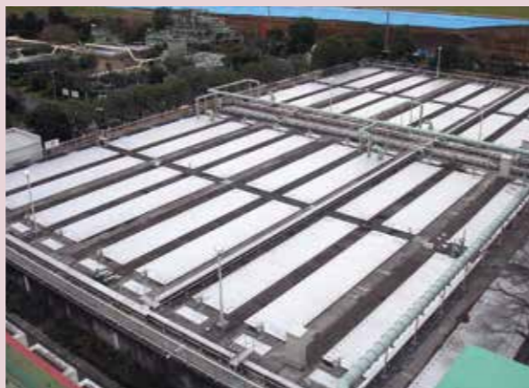
▲雨天時貯留池(北側)の上部
