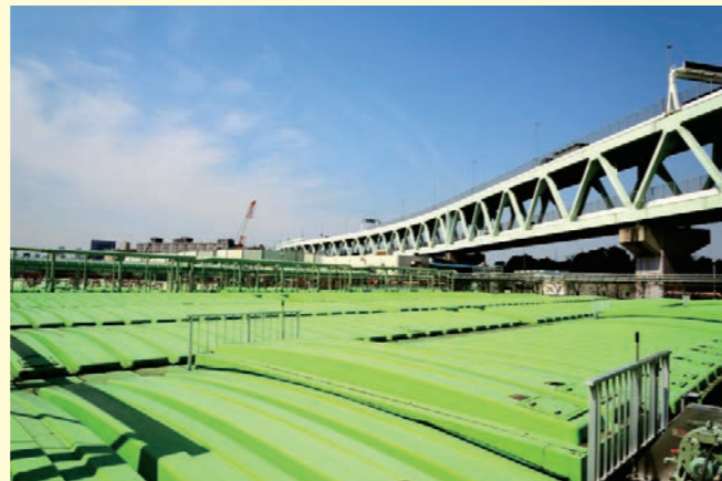
▲みやぎ水再生センターの水処理施設
