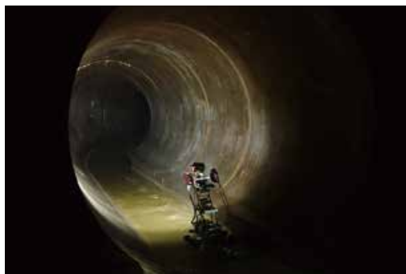
テレビカメラを用いた管路内調査
