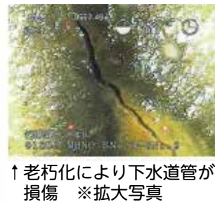
管内水位が高く老朽化した幹線（乞田幹線）
