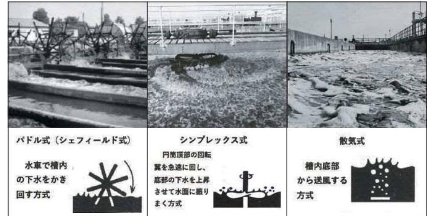
シンプレックス式は、円筒の頂部に取り付けた回転翼を急速に回転して円筒底部から下水を上昇させるとともに、周囲にはね飛ばしてエアレーションを行う。攪持翼で酸素溶解効率を高める反面、強力な回転により活性汚泥のフロック<sup>1</sup>が破壊されやすく、また、回転軸が長いため軸受けが損傷しやすいなど、機械的なデメリットも抱えていたといわれる。
