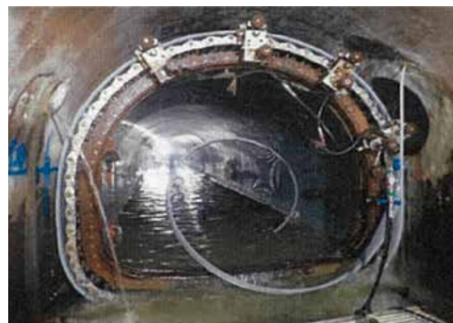
更生工法による幹線再構築（谷田川幹線）
