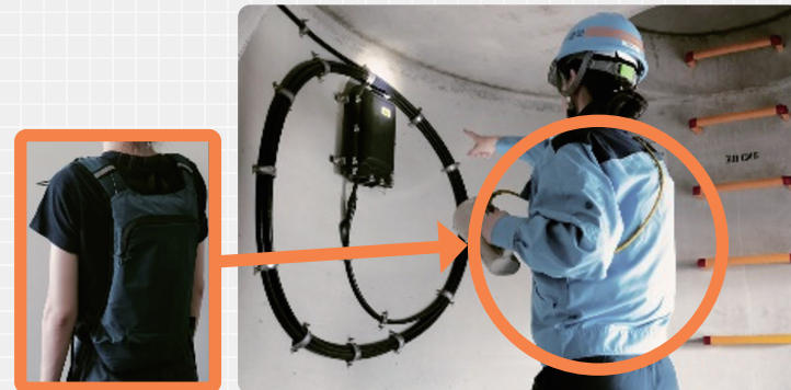
夏場の気温や湿度が高い現場で安全・快適に作業できるよう 水冷服を着用した例
