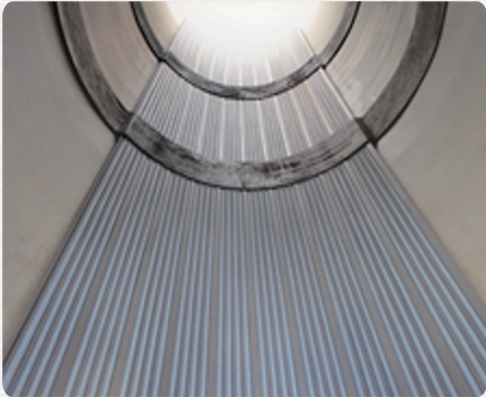
下水道管への熱交換器導入例
