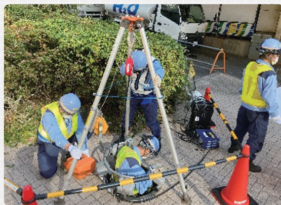
TGS社員による維持管理作業(下水道管、機器の点検)
