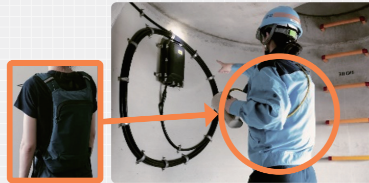
夏場の気温や湿度が高い現場で安全・快適に作業できるように水冷服を着用した例
