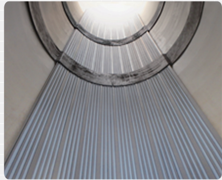
下水道管への熱交換器導入例
