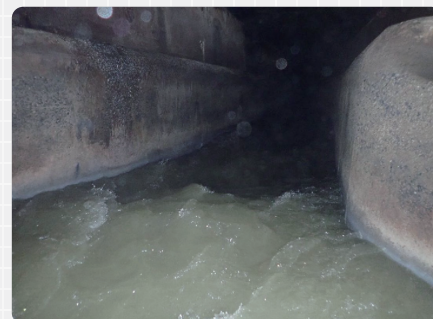
管内水位が高い下水道幹線
