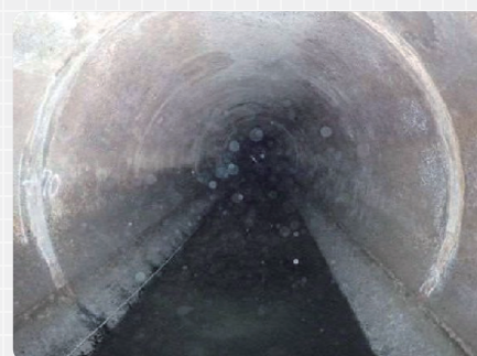
シールド工法で施工された下水道幹線
