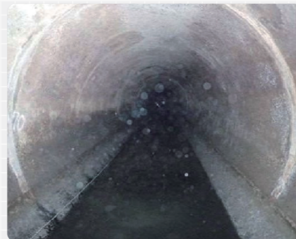
シールド工法で施工された下水道幹線
