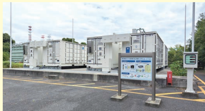
▲砂町水再生センターのNaS電池
