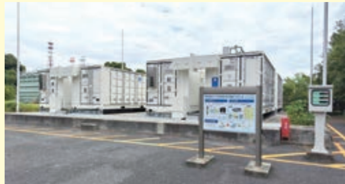
▲砂町水再生センターのNaS電池
