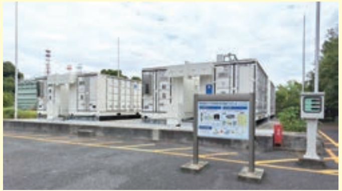
▲ 砂町水再生中心的NaS电池
