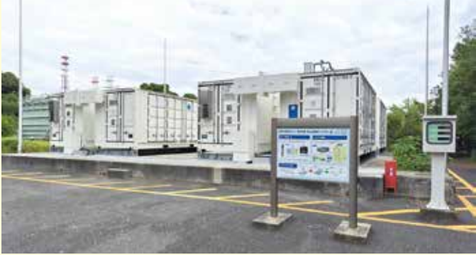
▲砂町水再生センターのNaS電池
