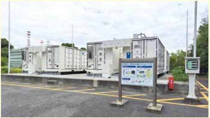
▲ 砂町水再生中心のNaS電池
