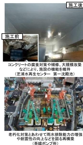
1 施設：水再生センター・ポンプ所の土木構造物や建築構造物
