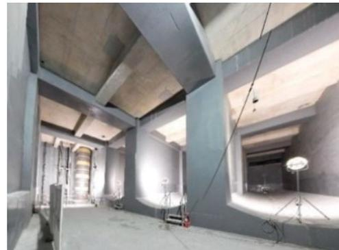
渋谷駅東口の地下に貯留容量約4,000m<sup>3</sup>の貯留施設を整備し、令和2年8月より取水開始
