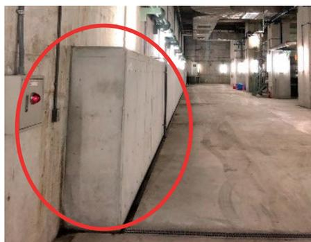
壁の厚みを増して耐震補強が完了した状況
