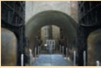
⑦ 泵井防水门室和水路 分为两个系统流入的污水在这里汇合，流入各自的吸水井。
