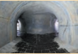
⑦ 泵井防水门室和水路 分为两个系统流入的污水在这里汇合，流入各自的吸水井。
