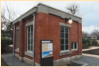
⑤ 主运车牵引装置用电动机室 安装的机器可把装有污水中清除出的沙土和垃圾的挖泥车吊上坡。
