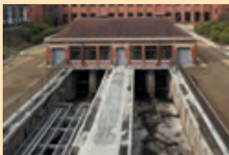
③ 沉沙池 东西各有 1 池，让污水在池中缓慢流动，沉淀并清除污水中的沙土。
