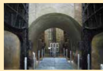
⑦ 吸水井连接暗沟及吸水井 分为两个系统流入的污水在这里汇合，流入各自的吸水井。
