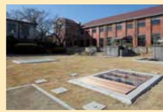
⑥ 量水器房 地下安装的文丘里流量计可测量污水量。
