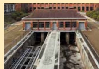
③ 沉沙池 东西各有1池，让污水在池中缓慢流动，沉淀并清除污水中的沙土。
