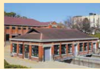
④ 滤格室棚 安装的钢网可清除污水中垃圾。
