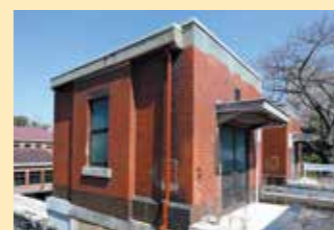
② 入口阻水门室临时屋顶 东、西各有1房，地下有维修时暂时阻止下水道水流的门。
