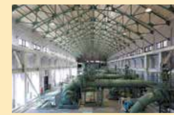
⑧ 泵房 安装的10台泵可把污水从地下的吸水井吸上来。
