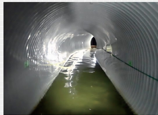
下水道管の内面を補強しリニューアルする更生工法による再構築
