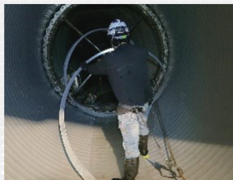
更生工法による幹線再構築
