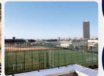
施設の上部を公園に利用
