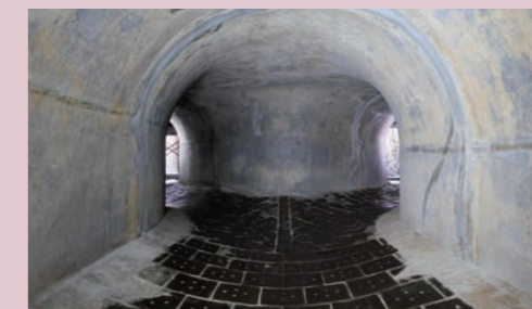
▲唧筒井接続暗渠
