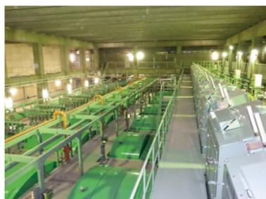
再構築した沈砂池機械設備
