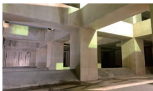
▲南砂雨水調整池。25mプール約80ぱい分の雨水をためることができる。
