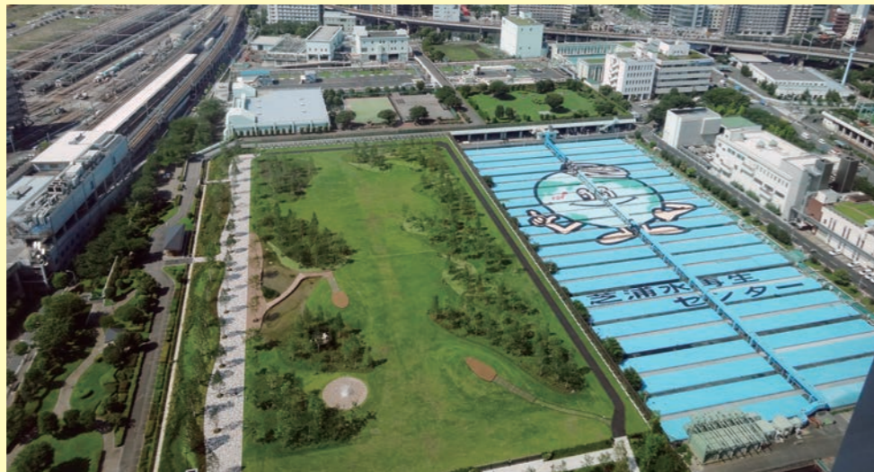
▲施設上部を芝浦中央公園として開放しています
