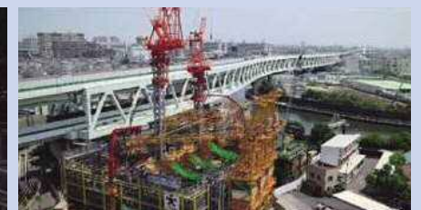
王子第二ポンプ所
