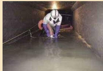
<管路内清掃の様子>
