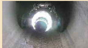
<管路内調査の様子>
