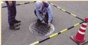
<マンホール蓋点検の様子>
