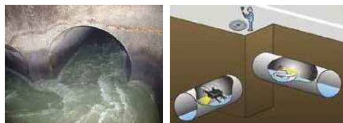
高水位の下水道管 遠隔制御による調査のイメージ
