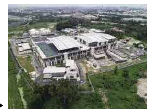
ランガット下水処理場▶
