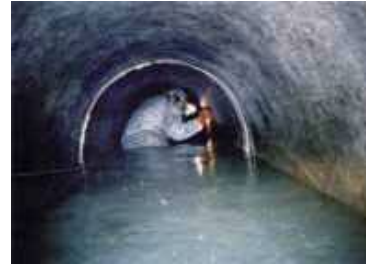
人力による下水道管内の調査
