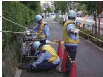
簡易なテレビカメラによる取付管の調査
