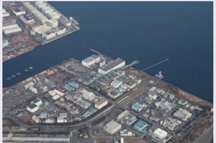
▲ 南部スラッジプラント
