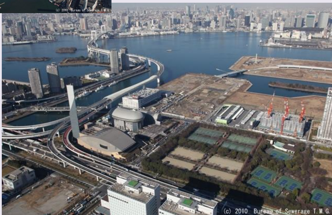
▲ 「有明のテニスの森公園」のテニスコートの下には下水の処理施設があります。
